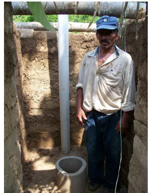
Las Delicias latrine nearing completion
